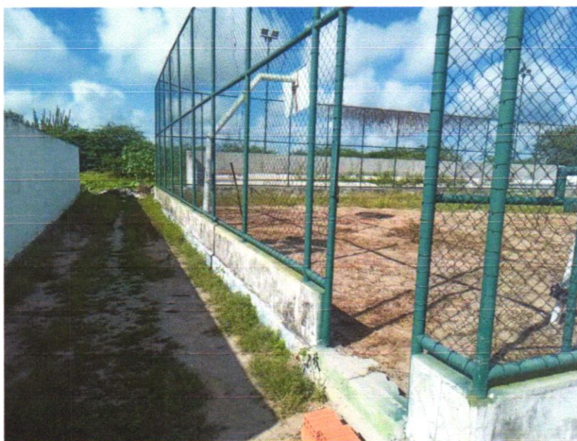
Foto 01 - LIMPEZA MANUAL DO TERRENO COM RASPAGEM SUPERFICIAL (CAPINAÇÃO)
