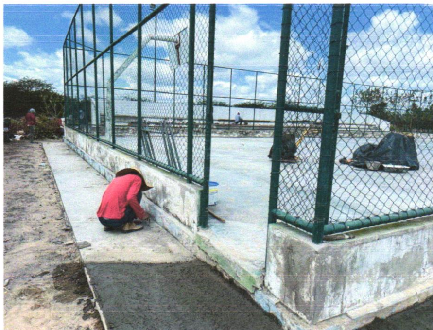
Foto 11 - ALAMBRADO PARA QUADRA POLIESPORTIVA, ESTRUTURADO POR TUBOS DE AÇO GALVANIZADO, (MONTANTES COM DIÂMETRO 2", TRAVESSAS E ESCORAS COM DIÂMETRO 1 ¼ ), COM TELA DE ARAME GALVANIZADO, FIO 10 BWG E MALHA QUADRADA 5X5CM (EXCETO MURETA). AF_03/2021
