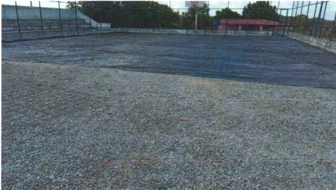
Foto 03- LASTRO DE BRITA GRADUADA APLIADA E=10CM
