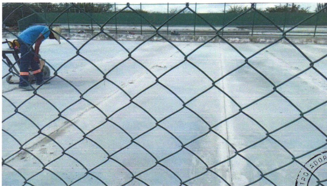
Foto 08 – EXECUÇÃO DE JUNTAS DE CONTRAÇÃO PARA PAVIMENTOS DE CONCRETO. AF_11/2017
