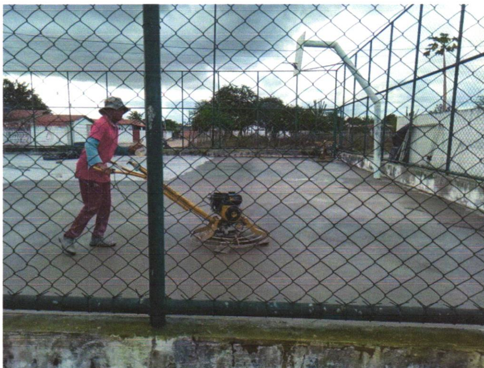
Foto 09- ACABAMENTO POLIDO PARA PISO DE CONCRETO ARMADO DE ALTA RESISTÊNCIA. AF_09/2017
