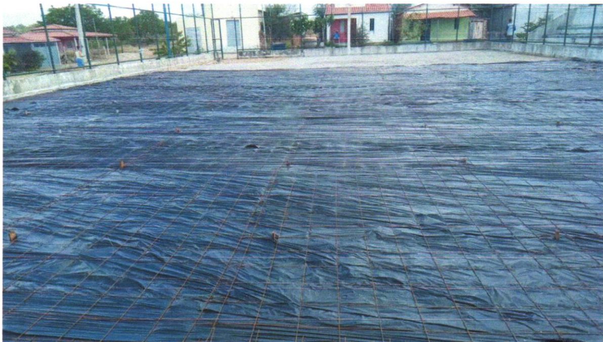
Foto 04 - APLICAÇÃO DE LONA PLÁSTICA PARA EXECUÇÃO DE PAVIMENTOS DE CONCRETO. AF 11/201
